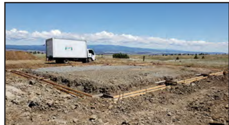
Ready to pour footings
